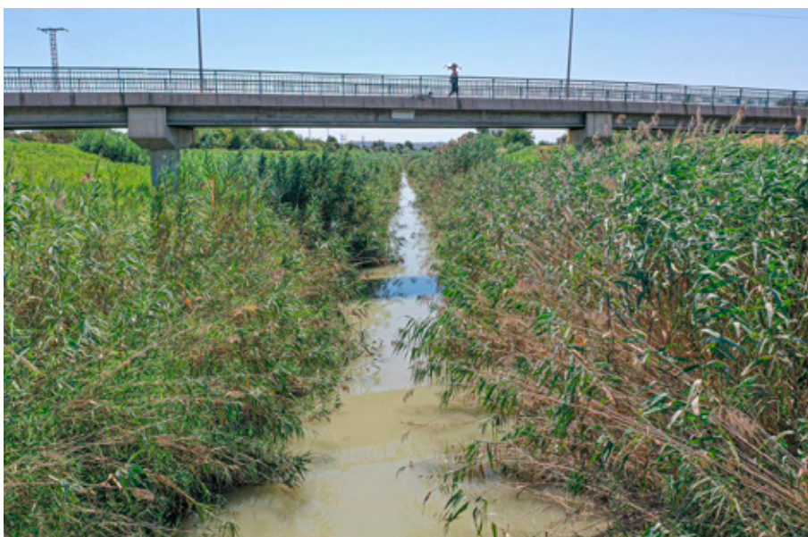
Cañas invasoras en el cauce del Río Segura.
